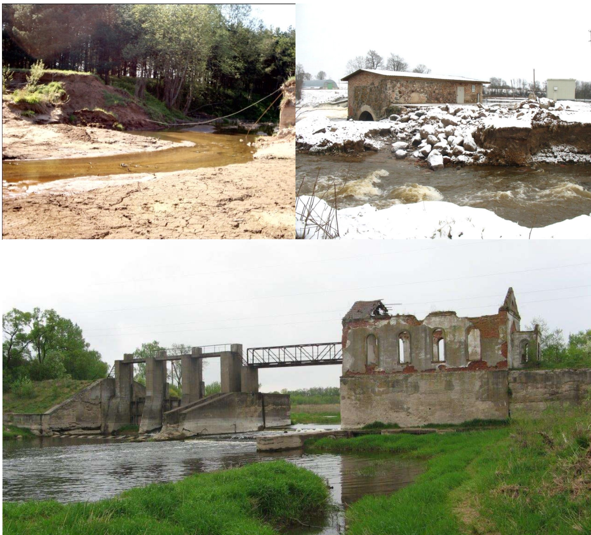
2 pav. Išplauti užtvankų pylimai Prienų r. sav. 2006 m. (viršuje, kairėje), Tryškių tv. 2011 m. Panevėžio r. sav. (viršuje, dešinėje), neprižiūrimi Kruosto tv. hidrotechnikos statiniai (apačioje).
